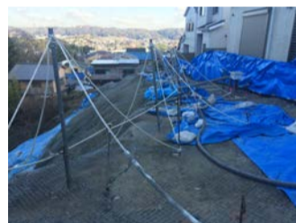
平成29年11月3日 暫定対策工事視察
